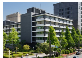
九段坂上KSビル
