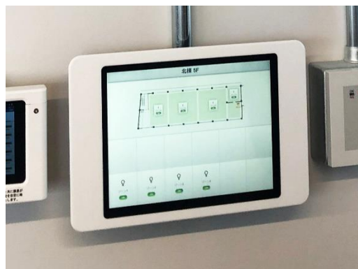
照明スイッチの切替ができるタッチレス操作盤
