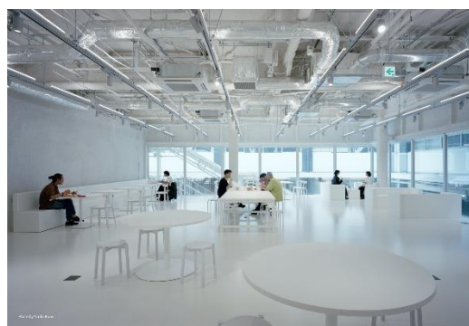
スケルトンにすることで広く開放的な空間に
