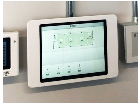
写真) 照明操作パネル。 ON/OFF したい照明が直観的にわかる操作画面となっている。
